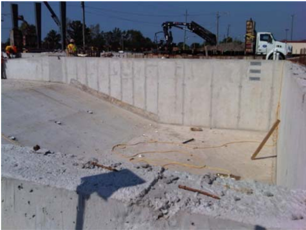
Lap pool concrete pour complete
